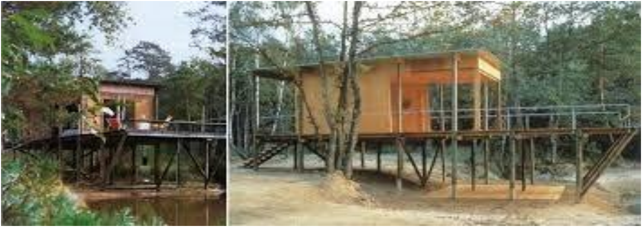
Maisons de vacances sur pilotis en zone inondable
